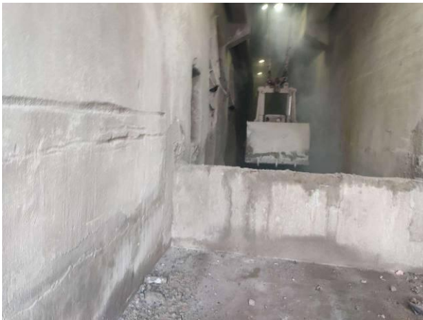
1#焚烧炉炉渣 (■1) 固体废物
