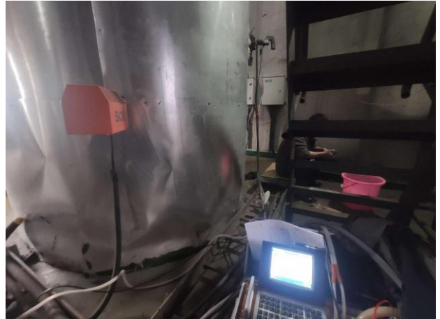
2#排气筒 DA002 (◎2) 有组织排放废气
